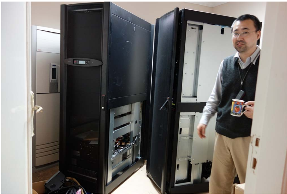
サクラビル1階に設置中のクラスタ(空調機と無停電電源装置のほうが大きい！)
